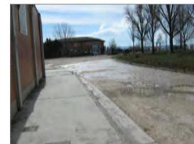
REBAJE EN ENCUENTRO DE RIGOLA Y EJECUCIÓN DE CAPA DE RODADURA
